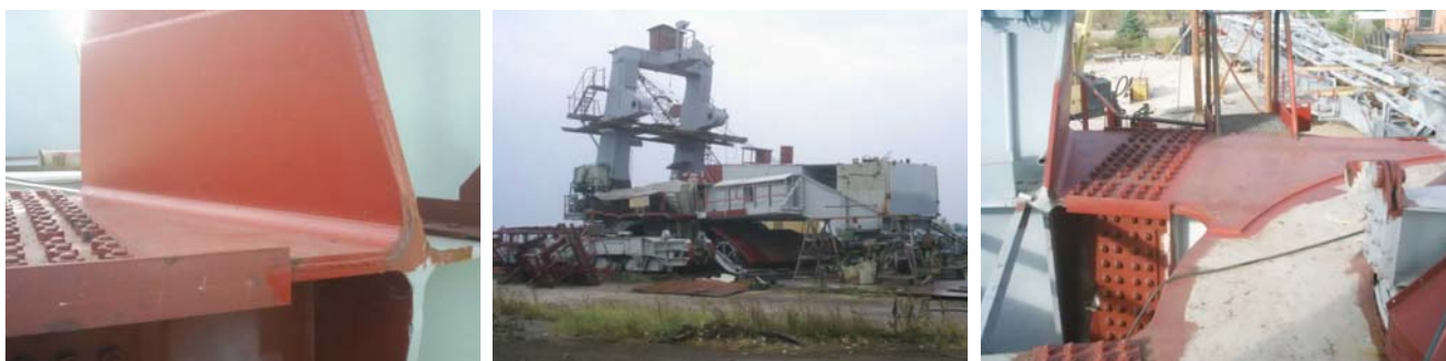
Slika 11. Izvedena sanacija i rekonstrukcija gornje gradnje Figure 11. Performed repair and reconstruction of upper assembly.
