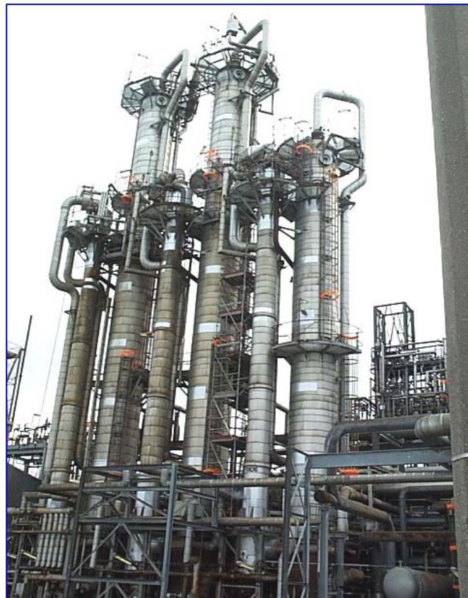
Slika 6. Označena mesta oštećenja korozijom ispod izolacije na kolonama, /3/
