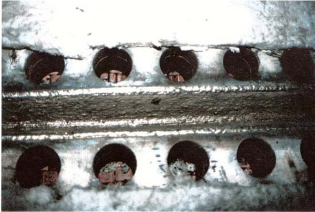
Slika 12. Nanošenje puterovanog sloja Figure 12 – Buttering layer deposition
