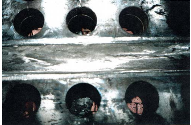
Slika 13. Brušenje puterovanog sloja Figure 13 – Grinding of the buttered layer
