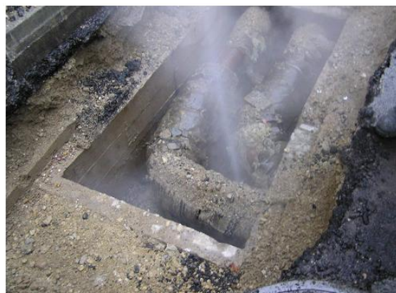
Slika 17. Detekcija curenja ukopanog toplovoda, /3/ Figure 17. Leakage detection of underground pipeline, /3/.
