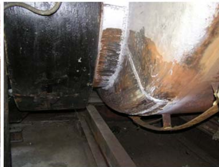
Slika 19. Segment zavaren za sanaciju danca
