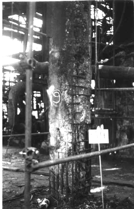
Slika 1. Oštećenja cevnih mostova
