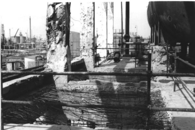
Slika 3. Oštećenja međuspratne ploče
