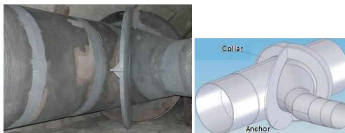
Izgled račve u HE Perućica i njen računarski model
