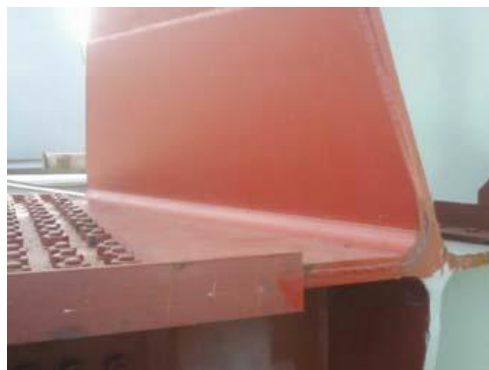
Izvedena sanacija i rekonstrukcija gornje gradnje
