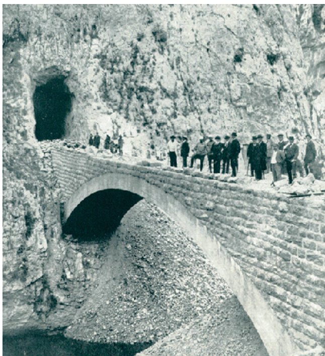
Slika 6. Nekadašnji izgled mosta na pruži Niš-Knjaževac 8 .
