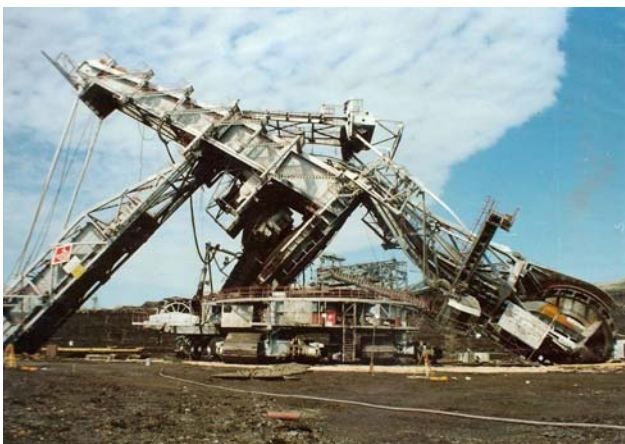
Slika – Lom konstrukcije bagera Figure – Excavator structural failure.
