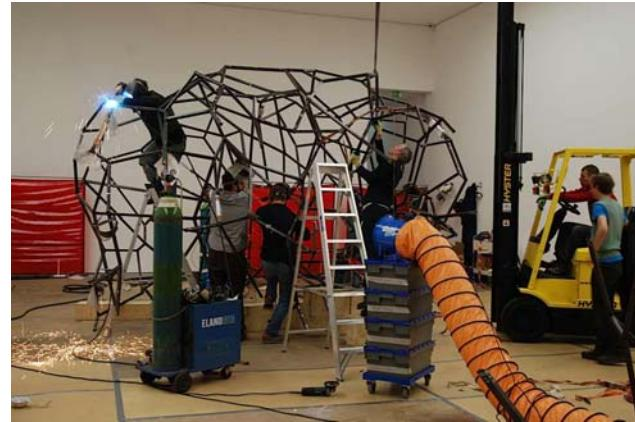
Slika 10. Zavarivanje poligonalne konstrukcije Farnsworth, /19/
