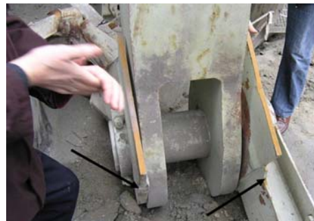
Figure 16. Fracture of two lugs on the counterweight holder caused the collapse of rotor excavator, /1/. Slika 16. Lom dve uške držača protivtega izazvao je kolaps rotacionog bagera, /1/
