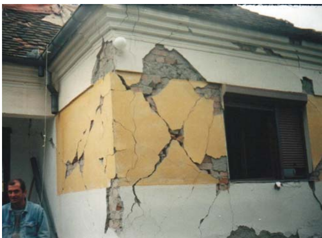
Figure 21. Example of damaged building in the Kolubara region. Slika 21. Primeri oštećene zgrade u području Kolubare
