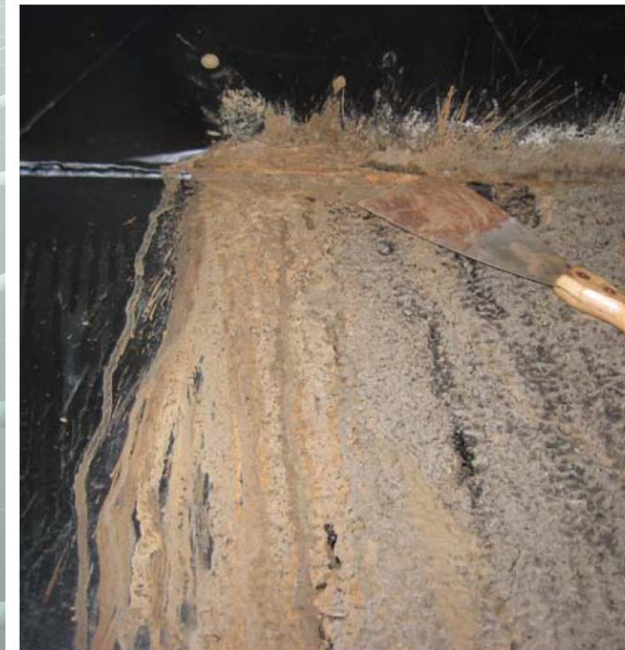
Низводни сандук, зона ПН 135` (ПН135`-ПН136`). Спој ОРТО плоче и узводног вертикалног лима. Пукотина у ОРТО плочи. шпахтла је увучена 18мм у пукотину.
